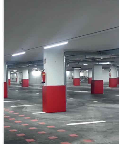
Ganze 184 Stück Säulen verkleideten wir mit unseren bewährten Prallschutzmatten, mit und ohne Lüftung – je nach spezieller Anforderung – in der Tiefgarage der Silvretta Montafon Bergbahnen.
